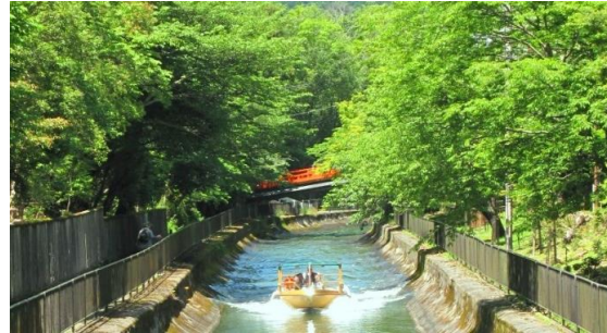
「びわ湖疏水船」運航風景(山科区)
